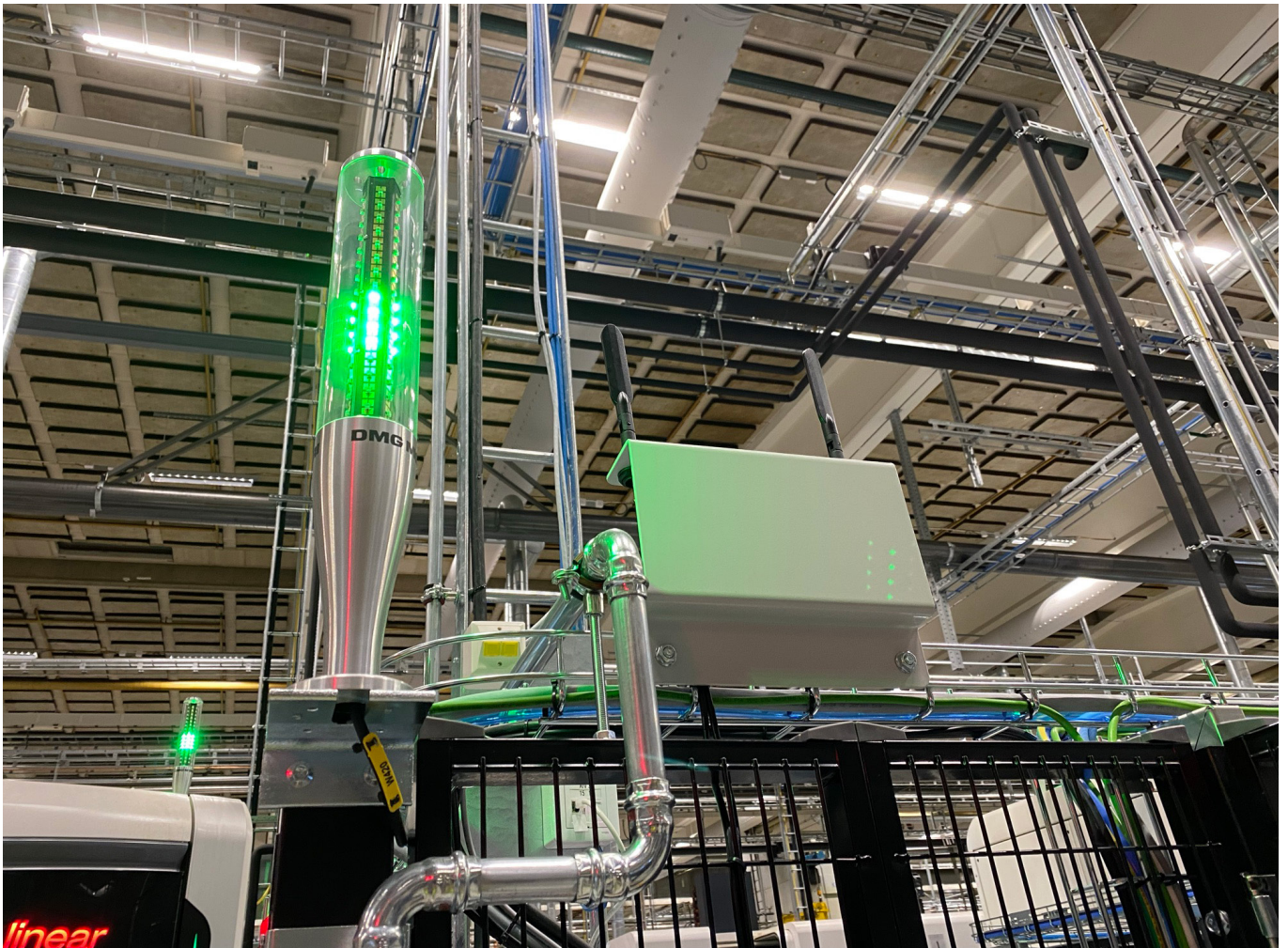
Anybus无线接入点具备网状网络功能，提供了出色的网络覆盖和无缝漫游，覆盖整个生产区域。
