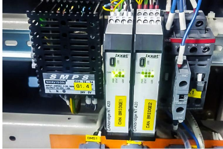
dows-basierte Konfigurationstool ermöglicht das einfache Konfigurieren der Bridges per USB. Es spielt eine zentrale Rolle bei der Anpassung und Übersetzung der CAN-Befehle für jede einzelne Batterieeinheit.
